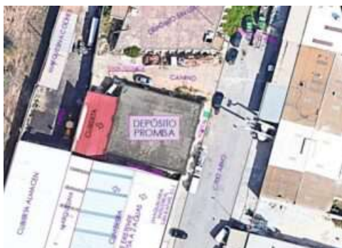
Un seno en ruina y sin inspeccionar desde 2019: así está el depósito que da agua a playa d'en Bossa
