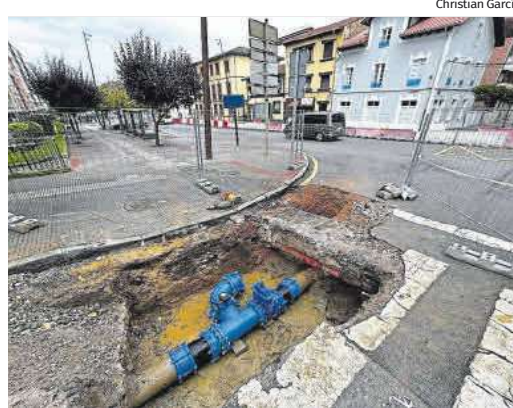
Tubería de la calle Eysines durante las obras.
