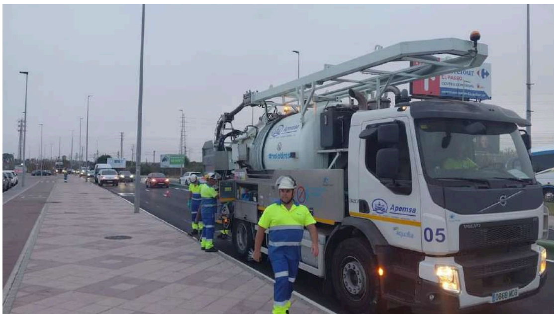
Labores de limpieza y mantenimiento de la red de alcantarillado y los imbornales. - AYUNTAMIENTO DE EL PUERTO DE SANTA MARÍA
