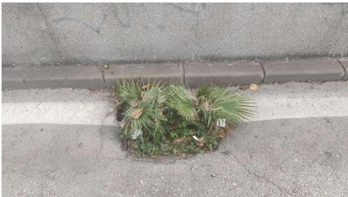
Imbornales obstruidos en Algeciras / IU
