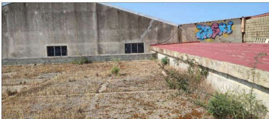
Imagen 7. Vista de la capa vegetal que cubre la cubierta existente.
